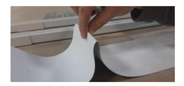
Ткань в месте залома складывается пополам (метки по краям ткани) и вставляется в паз металлической трубки
